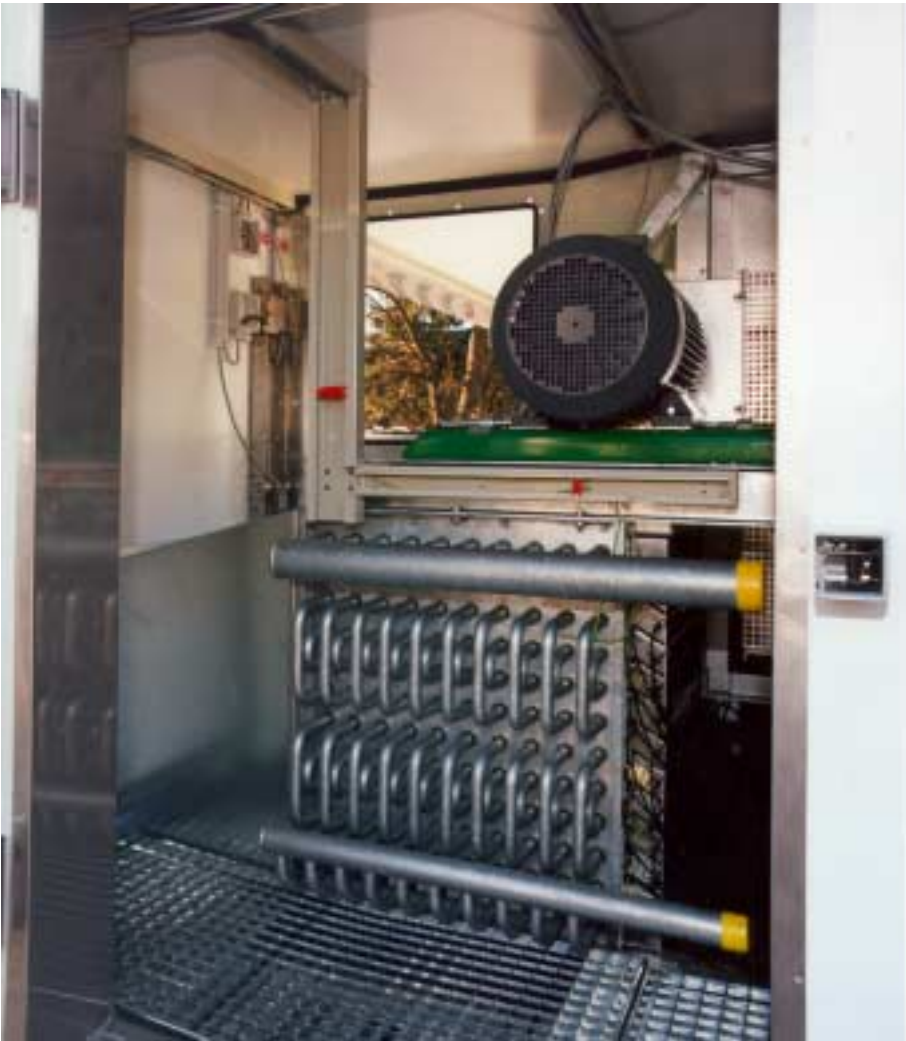
Wärmeaustauscherblock feuerverzinkt mit Antrieb für den Radialventilator
