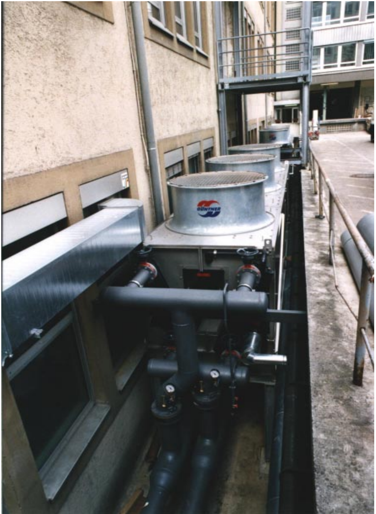
Bild 4 Montage des ersten von 3 zeichnungsgleichen Kühlern im 3 m tiefen und 2 m breiten Schacht. Die Kühlleistung dieses Kühlers beträgt 850 kW
