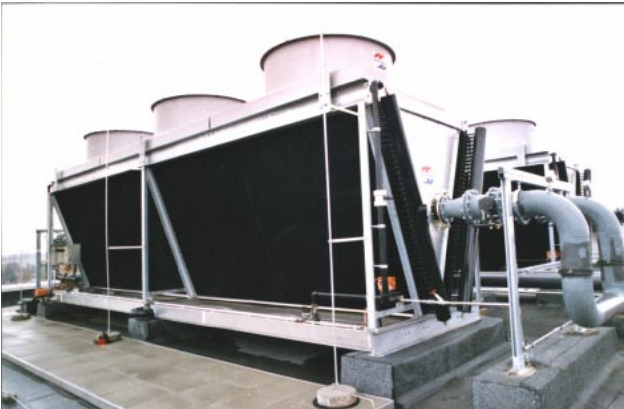
Bild 8: Hybride Trockenkühler für 3'533 kW Kühlleistung mit Mediumtemperaturen 36/28°C bei Luftzustand 32°C/38%, entsprechend einer Feuchtkugeltemperatur von 21°C.
